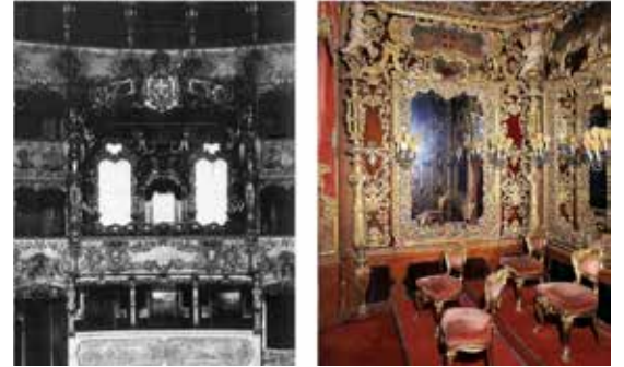
Solda: 1836 yangınında tahrip olan La Fenice, Giambattista ve Tommaso Meduna kardeşler tarafından kısa zamanda yeniden inşa edilerek 1837'de açıldı. Bu zamanda tekrar yapılan süslü kraliyet locası ise 1996 yangınında yok oldu. Sağda, Kraliyet locasının 1905'te parterden bakıldığı zamanki görünümü (Venedik Correr Müzesi).-
